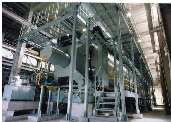
浄水場の脱水機据付
