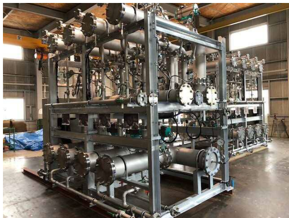
配管ユニット製作
