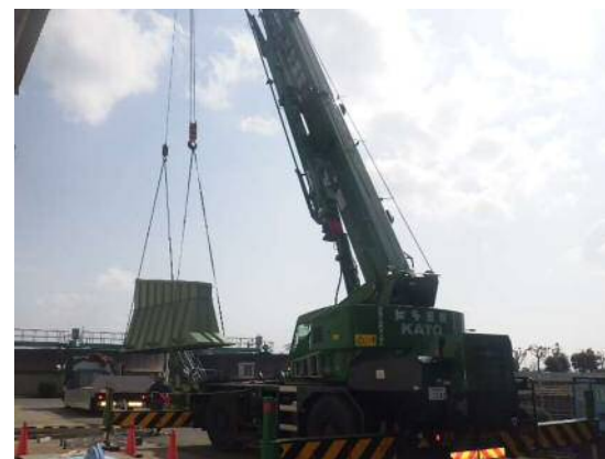
クレーンによる据付
